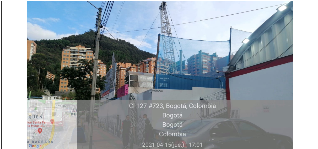
Foto 1. Vista panorámica del predio ubicado en la Av. Calle 127 No. 7-39 (dirección catastral), donde se evidencia que la estructura y paneles de la valla fueron desmontados.
